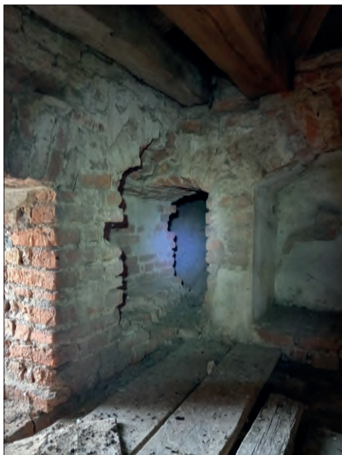
3. Łuków, kościół pobernardyński, przejście z północnej wieży na poddasze, fot. autor, 2023
