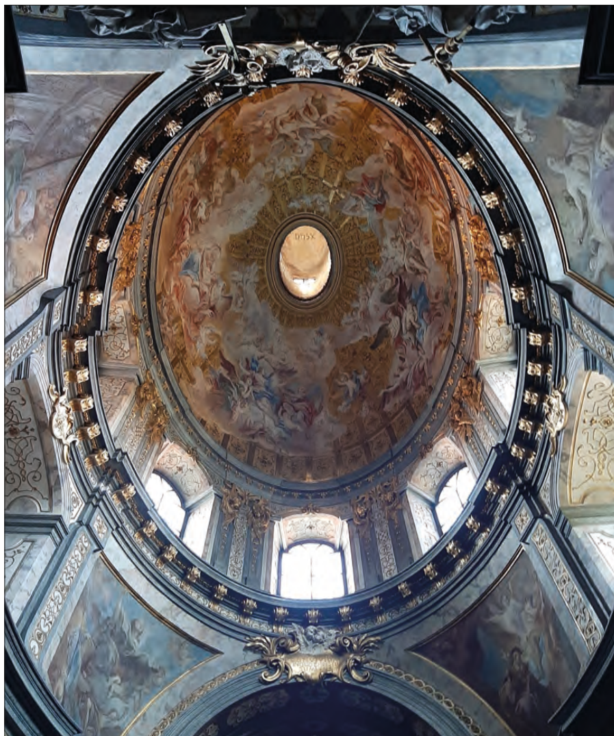
1. Katedra we Wrocławiu – kopuła w kaplicy elektorskiej, fot. autor, 2022
