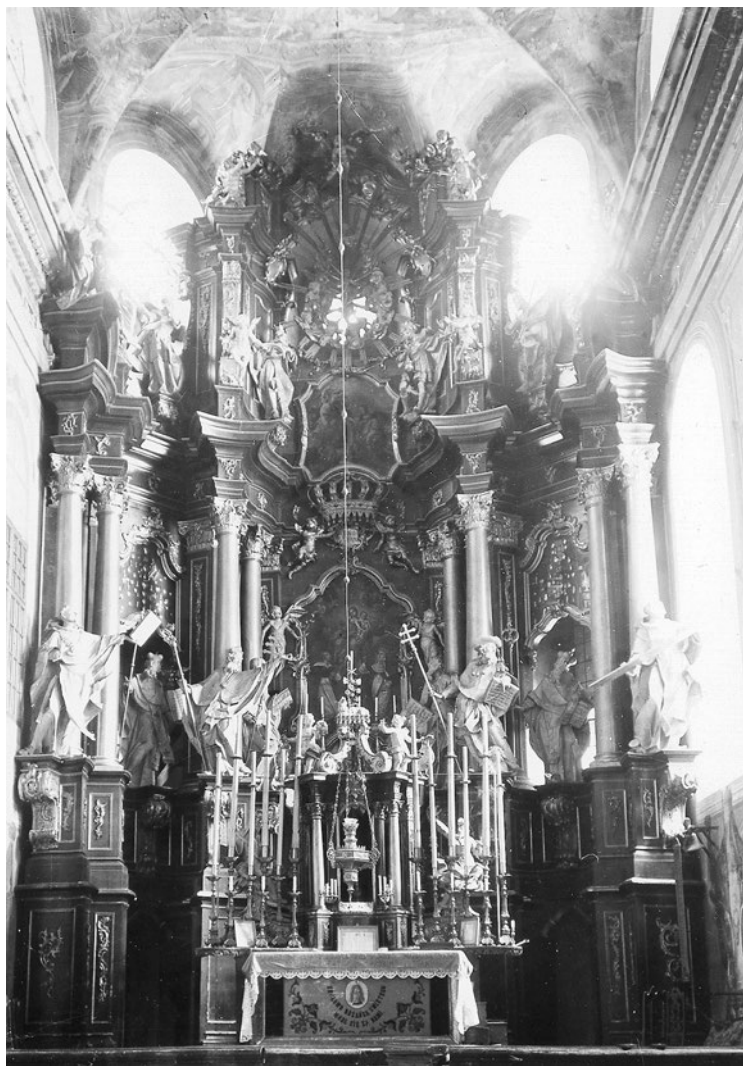
P. Polejowski (atryb.), Podkamień, kościół Dominikanów, ołtarz główny, 1764 – ok. 1766, fot. przed 1939
