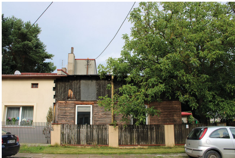
Fotografia 4. Drewniak przy ulicy Strażniczej 30/32
