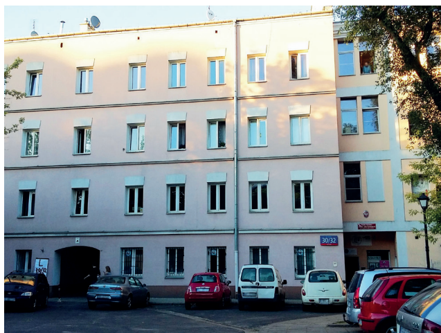
Rysunek 3. Budynek przy ul. Lubelskiej 30/32 w Warszawie Źródło: W. Uhlig, 27 maja 2017 r.
